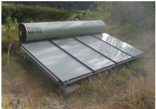
Calentador de agua con energía solar
